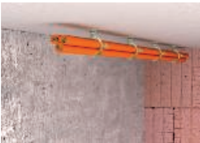
Kabelių grupės tiesimas po lubomis
