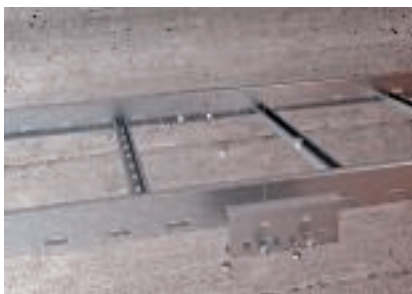
Tiesinių jungčių montavimas ovaliais varžtais
