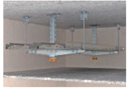
Dvisluoksnis kabinimas prie lubų išdėstant konsoles iš abiejų pusių
