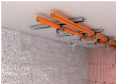
Pavienių kabėlių arba kabėlių grupės įrengimas
