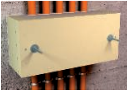
Apsaugos nuo laidų ištraukimo montavimas ant profiliinių elementų
