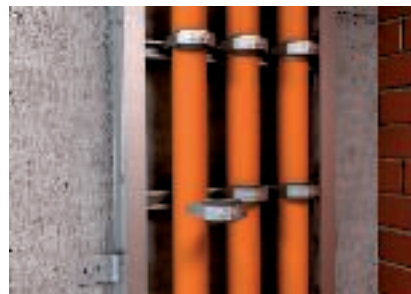
Kabelių įrengimas su apkabų gnybtais prie vertikalių kopėčių skersinių
