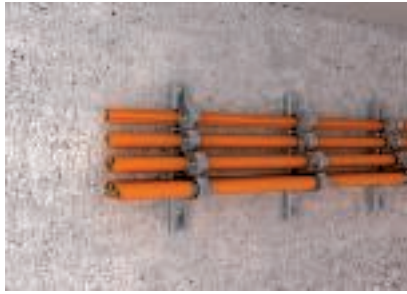
Horizontalus kabėlių montavimas ant sienos apkabų gnybtais
