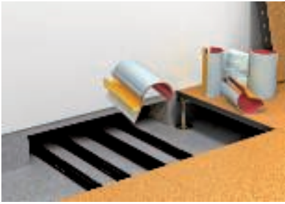
Pusės vamzdžio karkaso montavimas
