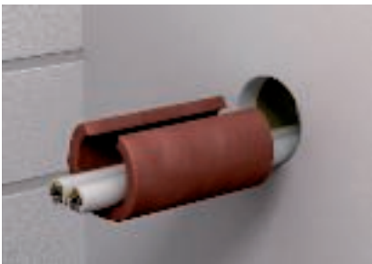
Jei kabeliai jau pakloti, prapjaunamas vamzdžių karkasas
