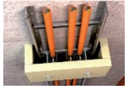
Apsaugos nuo laidų ištraukimo montavimas kartu su vertikaliomis kopėčiomis
