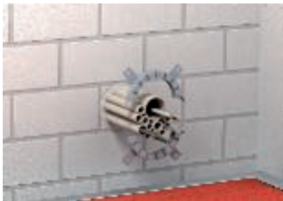
Abiejų veržiklio pusių sujungimas ir pritvirtinimas ant sienos
