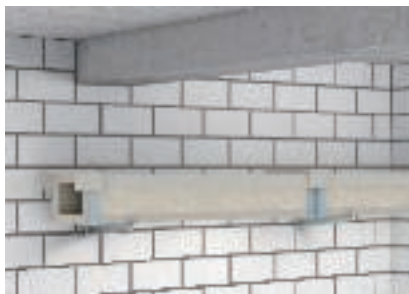
I tipo kanalo montavimas ant sienos
