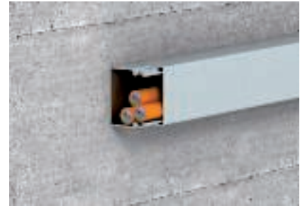
Švarus duomenų perdavimo ir įspėjimo apie gaisrą kabelių tiesimas 20030 tipo kanaluose
