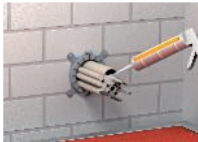
Vamzdžio galų užsandarinimas izoliuojančia medžiaga DSX
