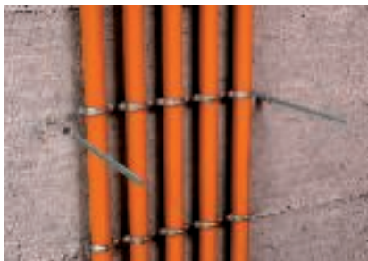
Tvirtinimo taškai ant sienos greta kabelių
