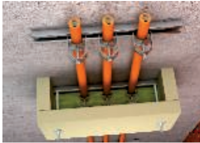
Apsaugos nuo laidų ištraukimo montavimas kartu tiesiant kabelius ant profiliinių bėgelių
