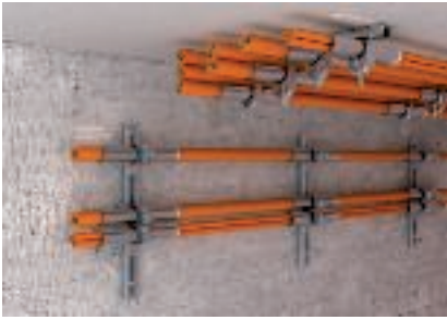
Horizontalus montavimas su apkabų gnybtais ir ilgosiomis vonelėmis ant sienos ir po lubomis
