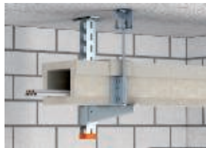
Montavimas kaip E kanalas su papildomu fiksavimu sriegiuotu juostu
