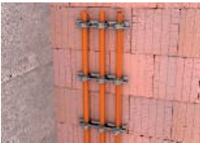
Vertikalus kabėlių montavimas ant sienos su apkabų gnybtais
