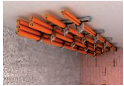
Horizontalus kabėlių montavimas apkabų gnybtais po lubomis
