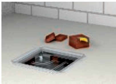
Išpjaukite siauras juosteles kanalų latakams.
