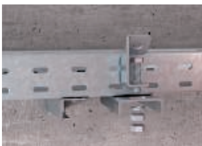
Įstrižo jungiamojo komponento pritvirtinimas
