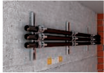
Vietą taupanti kelių vamzdžių įrengimas greta vienas kito su apkabomis-laikikliais
