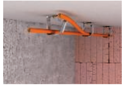
Lengvas kabelių įdėjimas į atidarytą grupinę atramą
