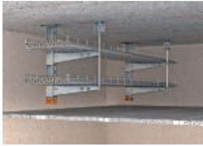
Dvisluoksnis kabinimas prie lubų išdėstant konsoles iš vienos pusės
