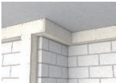
Lankstus kanalo tiesimas su individualiai pagaminamomis tvirtinimo detalėmis
