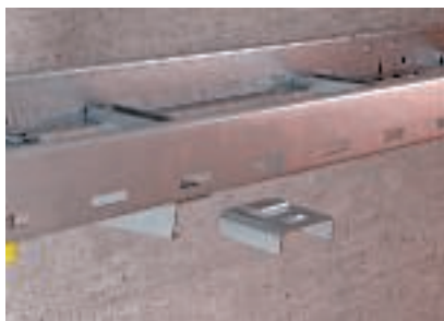
Jungiamojo komponento užmojimas ant kopėčių sijos apatinės juostos
