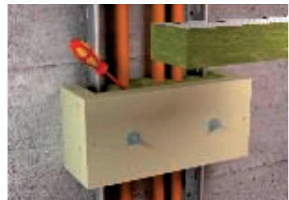
Mineralinės vatos užpildas lankščiam kabelių išdėstymui
