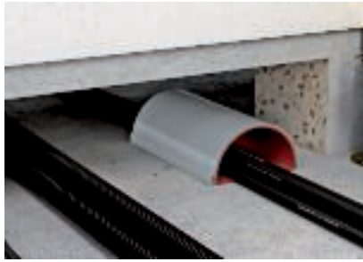
Pusės vamzdžio karkaso įdėjimas į izoliacinę ertmę
