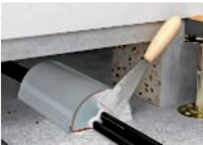
Paviršiaus užsandarinimas dūmams atsparia dengiamąja mase ASX
