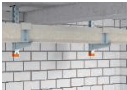
Kabantis montavimas prie lubų kaip I-kanalas
