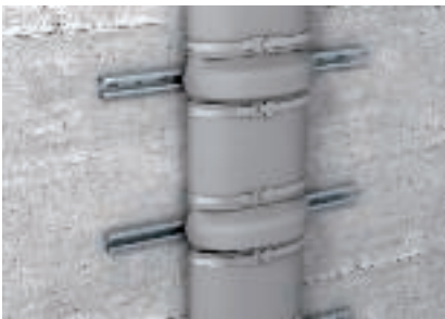
Apvijos pritvirtinimas metaline tampria juosta įrengiant bėgelius
