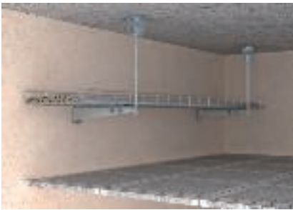
Montavimas prie sienos, galimas vienu ir dviem sluoksniais
