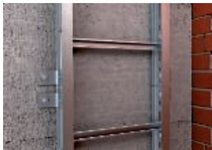
Tiesioginis kopėčių montavimas ant masyvių sienų
