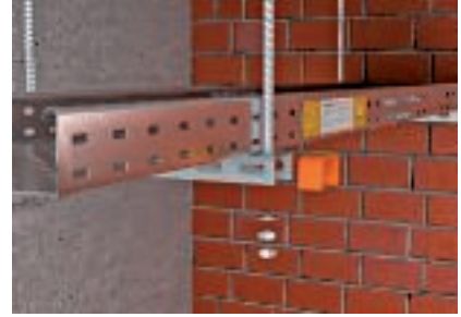
Srieguotųjų strypų montavimas šešiakampėmis veržlėmis ir didelėmis poveržlėmis
