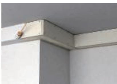
Galutinis paviršiaus apdorojimas jį nudažant arba tapetuojuant
