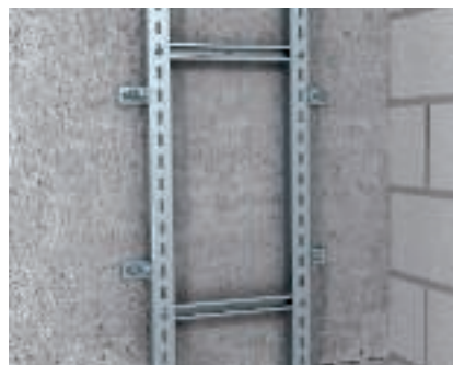
I formos sunkiojo profilio tvirtinimas prie sienos SLM 50 tipo sunkiųjų vertikalių kopėčių tvirtinimas prie sienos, naudojant BW tipo tvirtinimo kampą.
