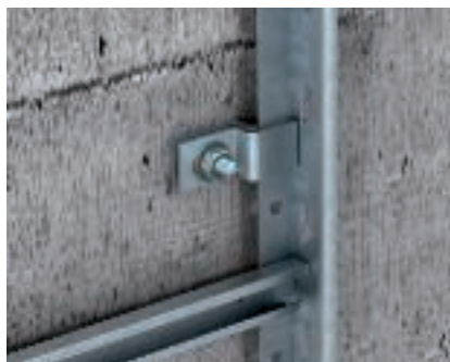
I formos lengvojo profilio tvirtinimas prie sienos SLL 45 tipo lengvųjų vertikalių kopėčių tvirtinimas prie sienos, naudojant WB 30/75 tipo sieninę apkabą.
