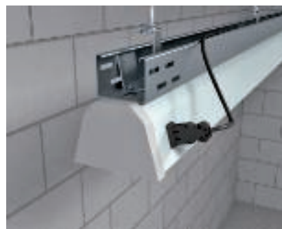
Iš anksto paruoštas šviestuvo tvirtinimas Iš anksto paruošto šviestuvo montavimas po šviestuvo tvirtinimo bėgeliu.
