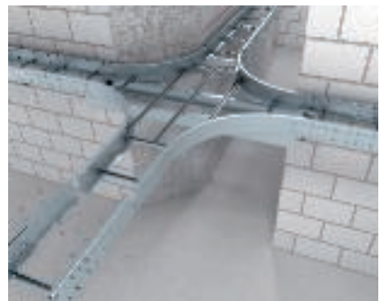
Kryžmės montavimas Alkūnė derinama su didelių atstumų tarp atramų kopėčiomis. Kryžmė jungiama su kabelių kopėčiomis naudojant išorinius sujungiklius.
