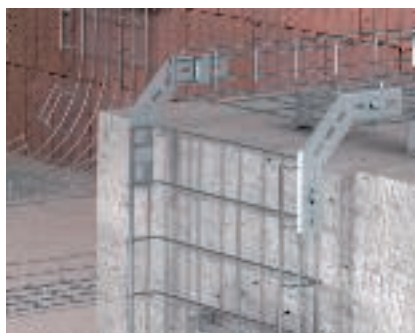
Atliktas montažas Paruoštos C vielinių lovelių sistemos montažo atvaizdavimas.
