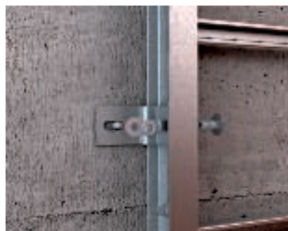
Pramoninių vertikalių kopėčių tvirtinimas Pramoninės vertikalios kopėčios tvirtinamos prie sienų BW80/55 tipo atraminiais kampais.
