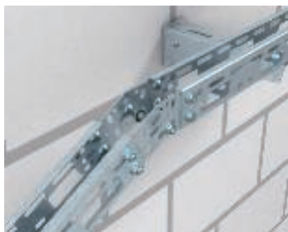
Vertikalusis tiesusis jungimas Vertikalusis tiesusis LTS tipo šviestuvinio lovelio jungimas dviejomis VF AZK tipo tiesiomis ir kampinėmis jungtimis.
