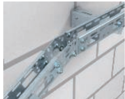
Vertikalusis tiesusis jungimas Vertikalusis kampinis AZ mažųjų kanalų jungimas, naudojant du VF AZK tipo sujungiklius.
