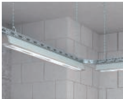
Šviestuvų lovelio tvirtinimas Šviestuvų lovelio tvirtinimo pakaba, naudojant grandinę ir kabinamąją apkabą.
