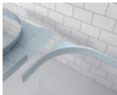
T formos atšakos realizavimas, naudojant kampinį jungiamąjį elementą Antrojo WEAS 110 tipo kampo jungiamojo elemento montavimas.
