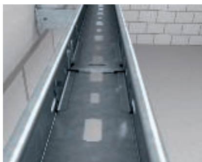
Tiesusis šviestuvinio lovelio jungimas Horizontalusis tiesusis LTR tipo šviestuvinio lovelio jungimas RV 607 tipo tiesiųjų sujungiklių rinkiniu.
