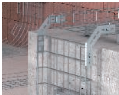
Atraminė konstrukcija su vertikalia alkūne Vertikalios alkūnės montavimas MW tipo montažiniu kampu pastatomuose C vieliniuose loveliuose.
